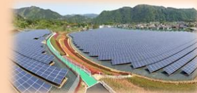
愛川太陽光発電所
