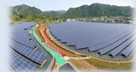
愛川太陽光発電所
